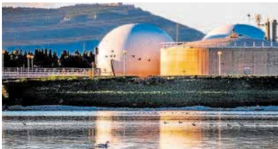
Depuradora Cabezo Beaza en Murcia
