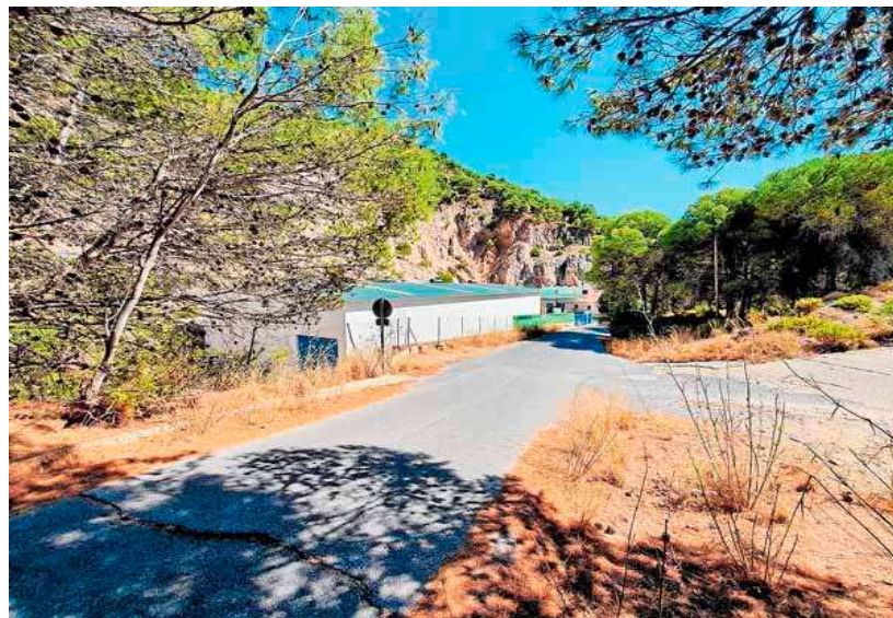
Vista del paraje y de las instalaciones de 'Aguas de Mijas'. sur
