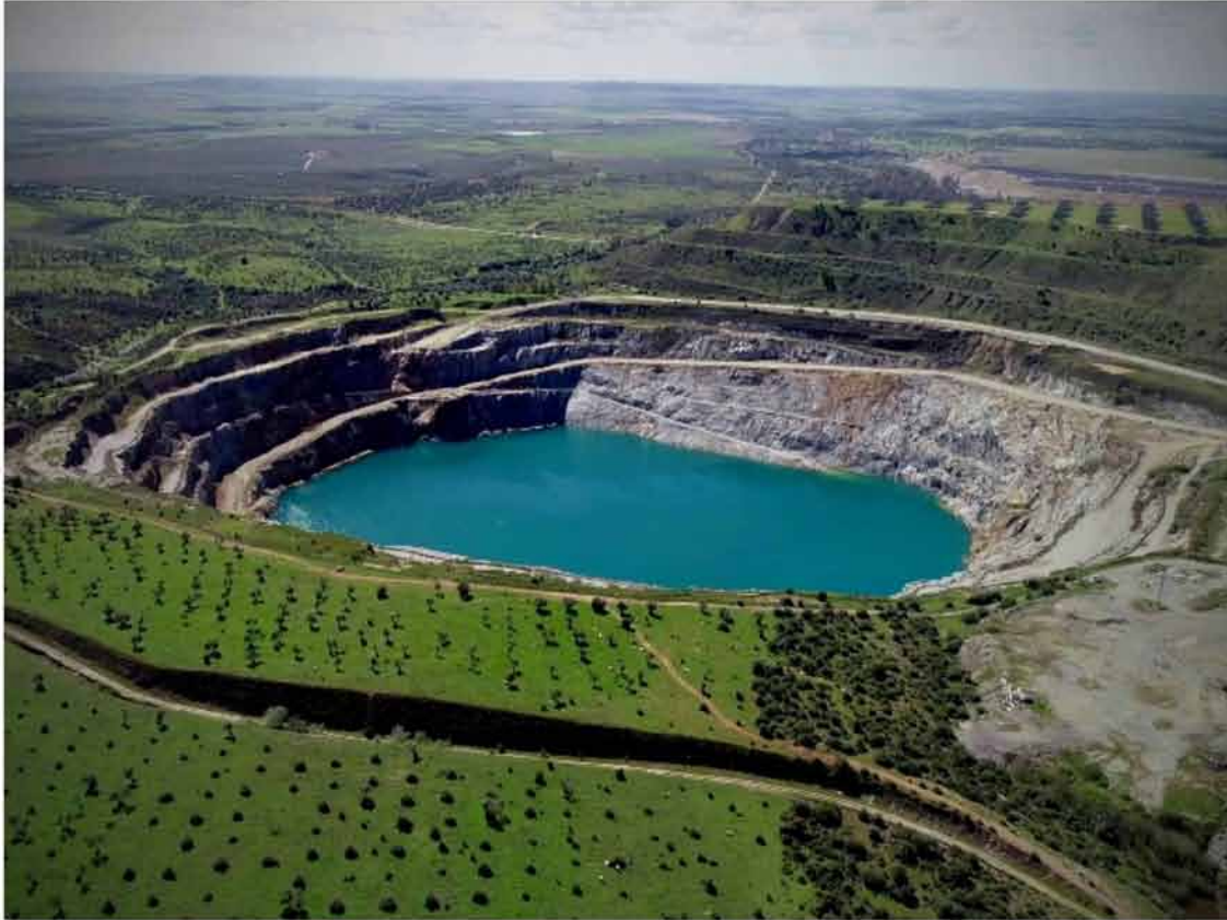
Corta Los Frailes, en Aznalcóllar, bajo la que se construirá la nueva mina subterránea una vez que se extraiga todo el agua embalsada. (Cedida)
