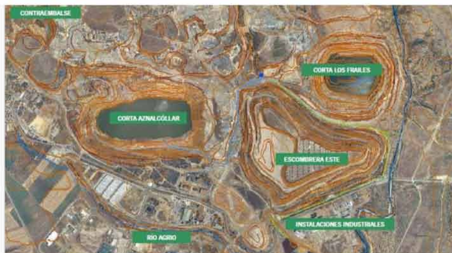
Vista aérea de las cortas llenas de agua y las escombreras de Aznalcóllar.
