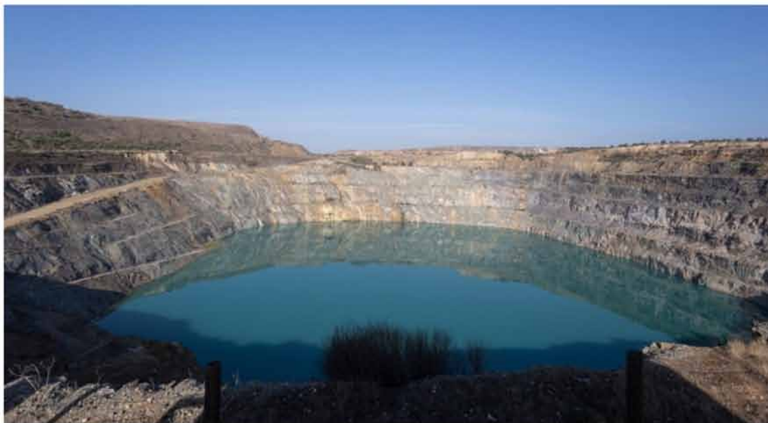
Minera Frailes preadjudica Aqualia construcción PTA Aznalcóllar
